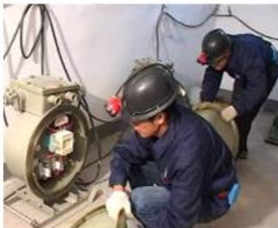
电器开关维修
